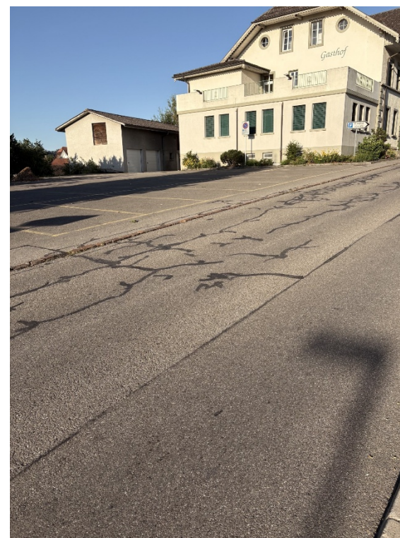
Abbildungen 3/4: Vergussmassen zur Verhinderung der Schadenausbreitung
