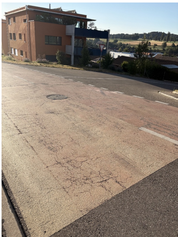
Abbildungen 1/2: Risse in der Oberfläche und Ausmagerungen im Belag
