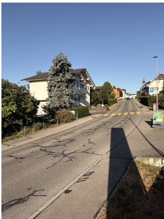
Abbildungen 3/4: Vergussmassen zur Verhinderung der Schadenausbreitung
