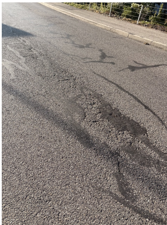
Abbildungen 1/2: Risse in der Oberfläche und Ausmagerungen im Belag
