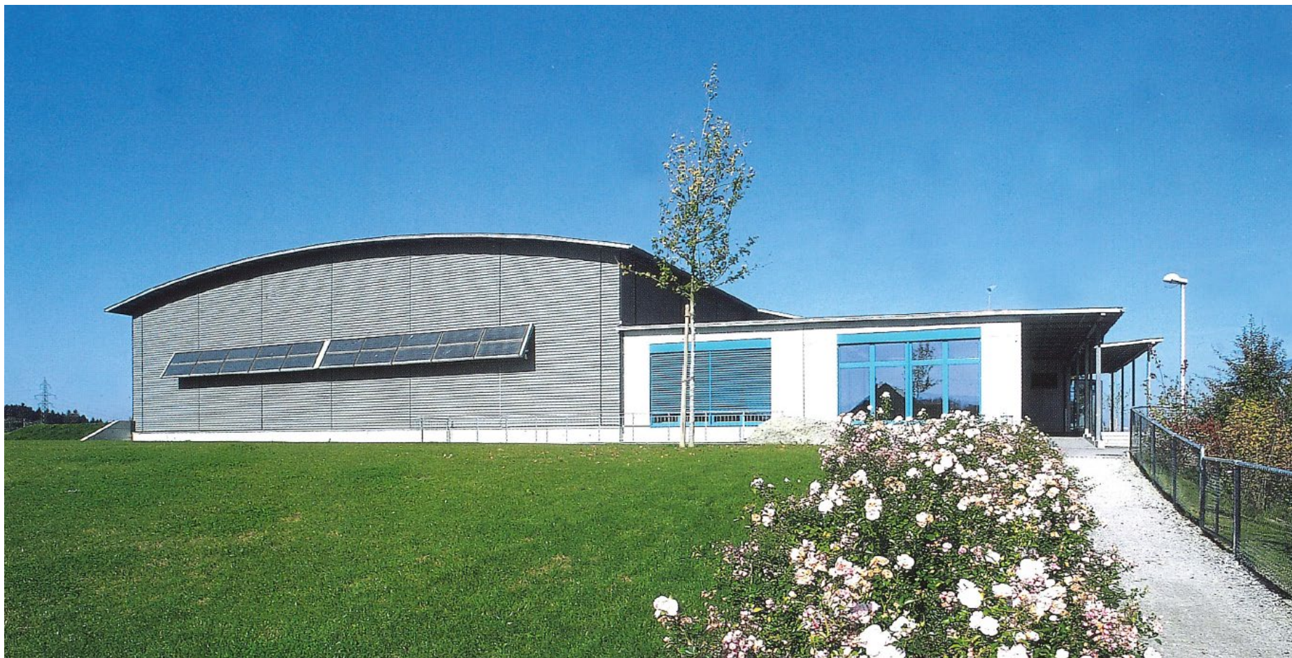
Sporthalle Wünnewil Südansicht – Blechtonnendach – Nebendach - Vordach
